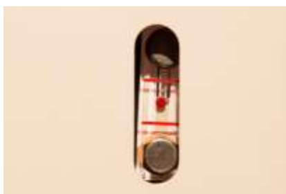
Controllo a vista livello olio idraulico e livello gasolio. Vano protetto da chiave contro gli atti vandalici.
